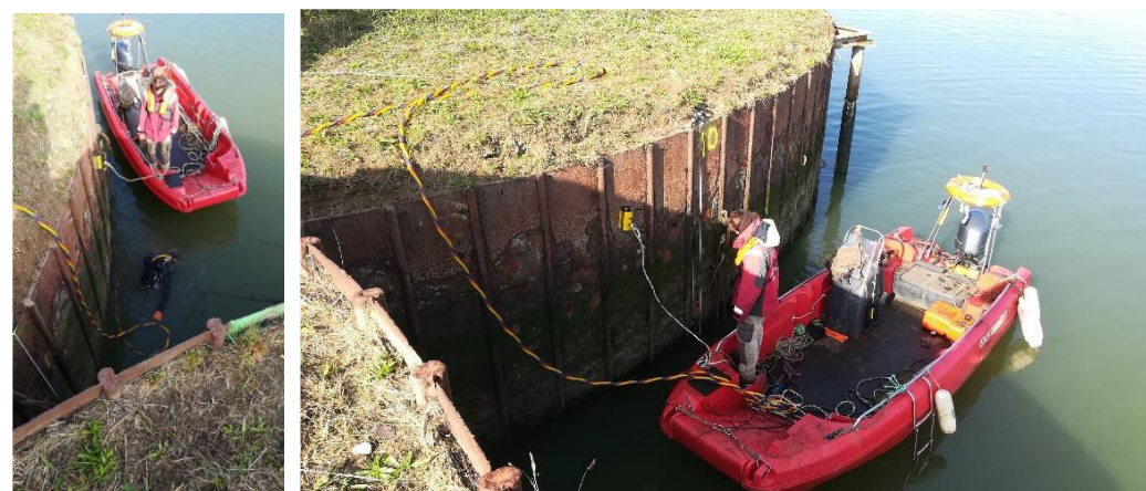
Figure 7 : Campagne de mesure de l'épaisseur des palplanches en 2018
